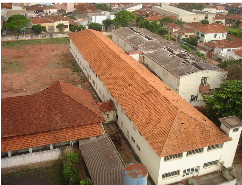
Figura 1.3 - Espaço Desconstruído Livre: antigo prédio do asilo de mendicidade abandonado há mais de cinco anos. Acima à esquerda, espaço vazio onde existiam a igreja de São Francisco e uma das alas, demolidas. Observa-se, ainda, prédio central e anexo à direita, onde residiam idosos em apartamentos pagos. À esquerda, abaixo, ala dos não pagantes. Foto: (MONTEIRO, 2007).
