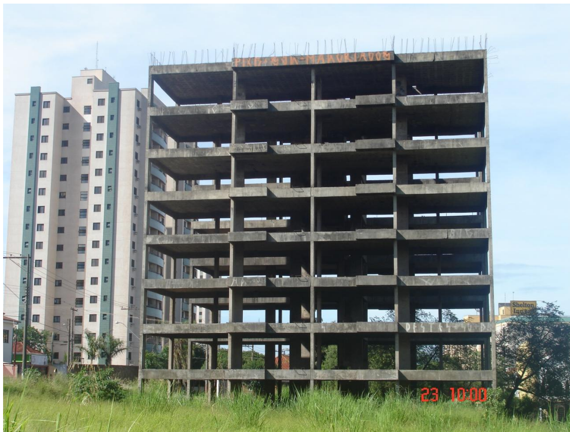
Figura 1.4- Espaço desconstruído livre na cidade de Araraquara-SP: prédio incorporadora/construtora ENCOL abandonado há mais de 10 anos. Ao centro, prédio inacabado da antiga construtora ENCOL, localizado nas imediações do centro (recentemente foi retomado na Justiça pelo antigo proprietário do terreno); contrasta com o prédio ao lado esquerdo e ao fundo, regularmente habitado. Foto:( MONTEIRO, 2009).
