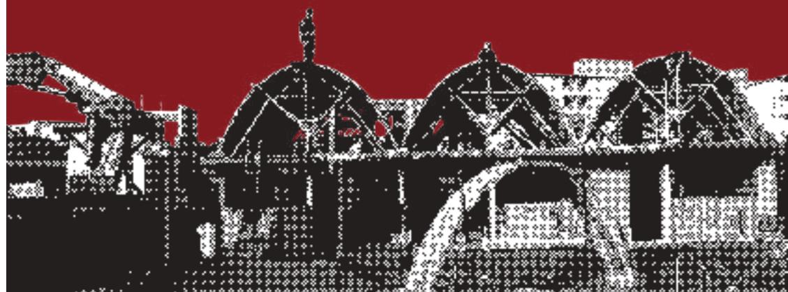
Fig. 75/76\_ Processo construtivo de abóbadas, Pq. São Rafael Arquivo USINA-CTAH
